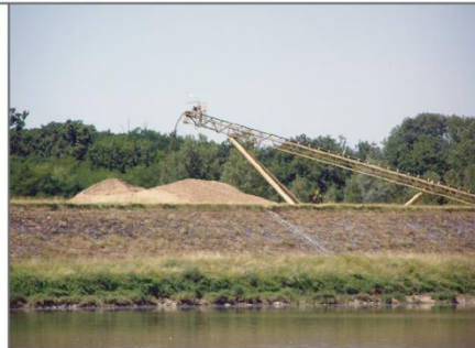
gravière en activité en rive gauche de Loire à Sandillon : sud-est d'Orléans (cl. 22/07/2008)
