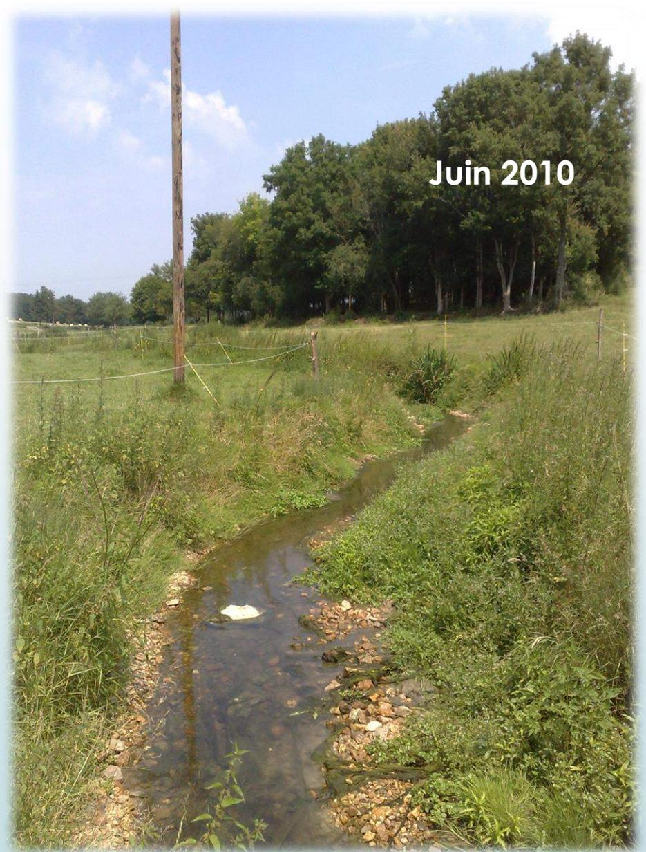
Suppression de l'ouvrage aval et recharge granulométrique
