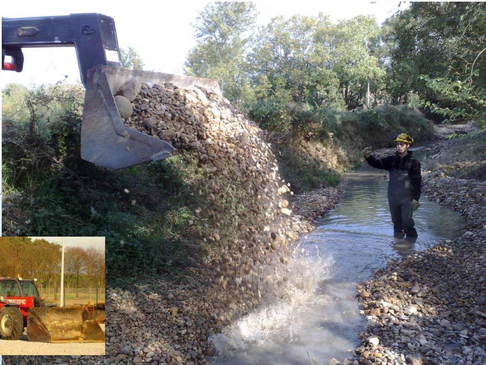
**Moyen de mise en œuvre : Manuscopique flèche de 10 m et godet d'1m3**
