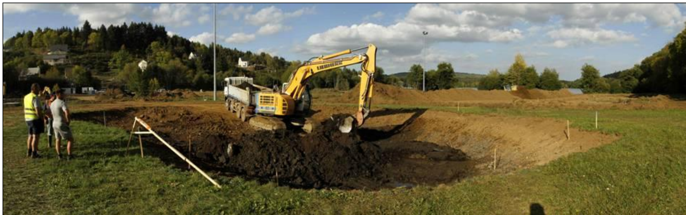
Terrassement de la zone humide
