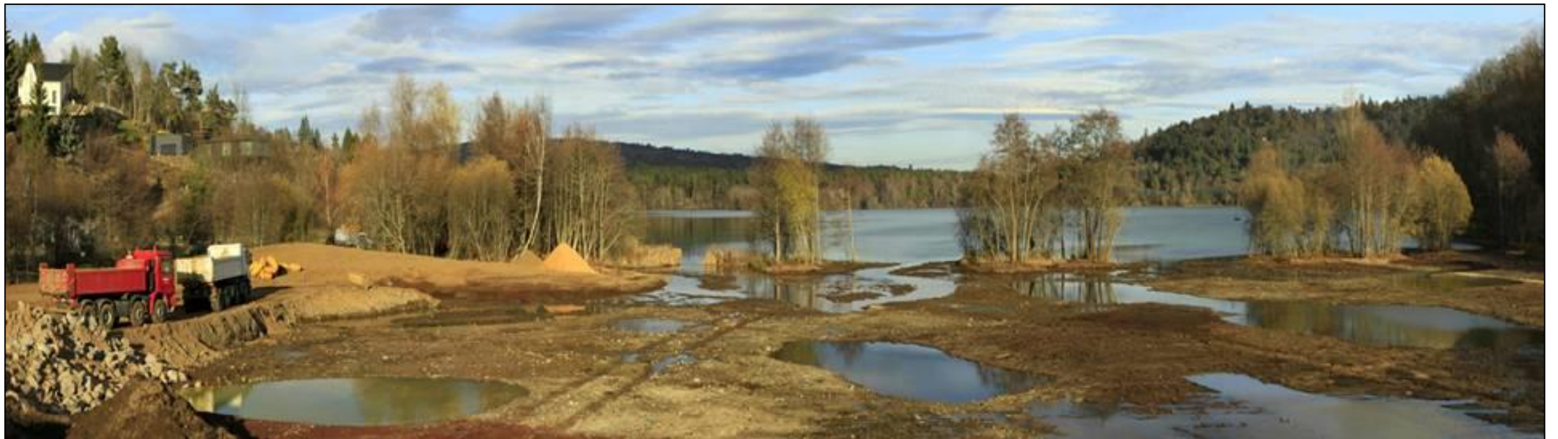
Terrassement de la zone humide
