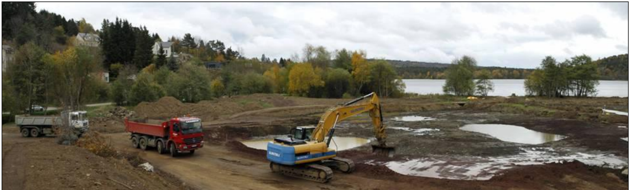
Terrassement de la zone humide
