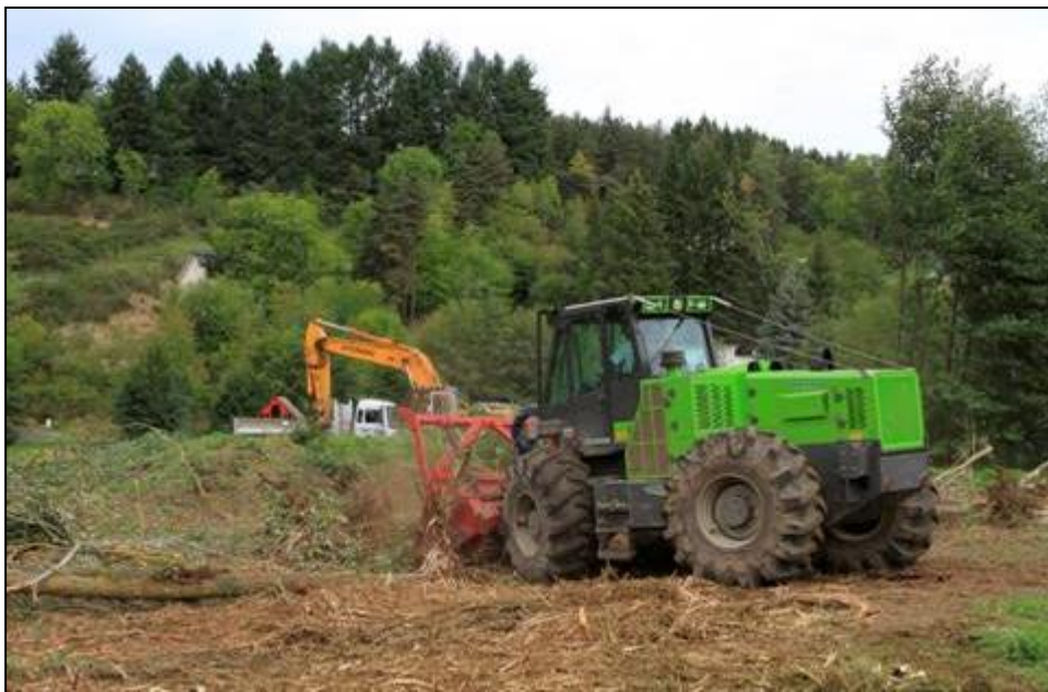
Nettoyage de la végétation
