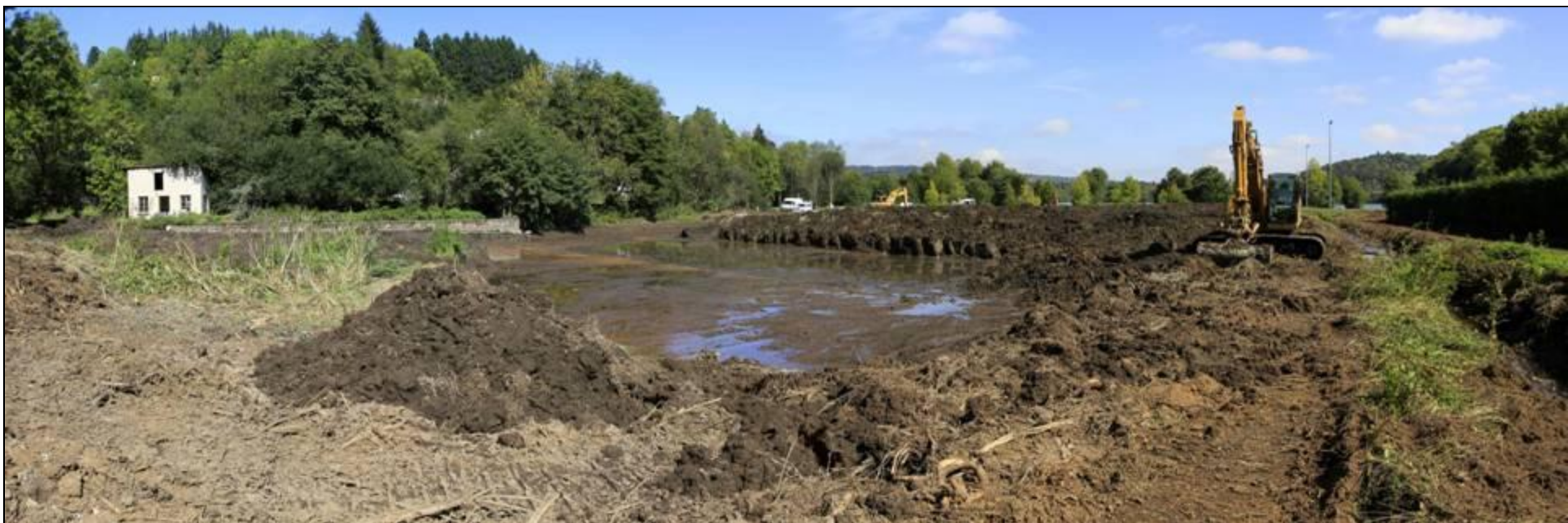
Curage des bassins
