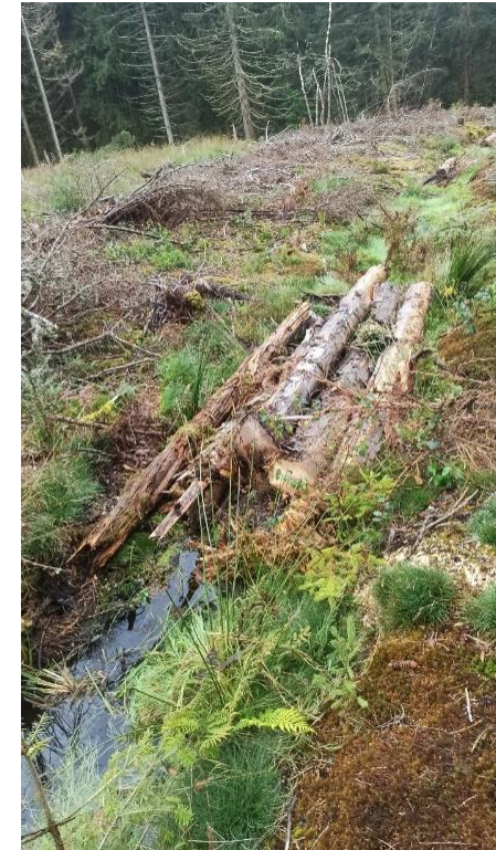
Bouchons réalisés sur un fossé de drainage.
