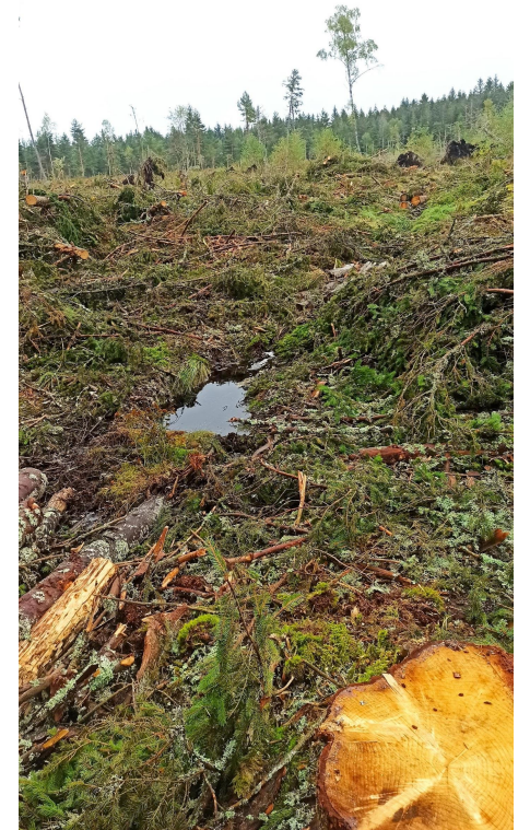
Bouchage de drain par le chantier JO 2021
