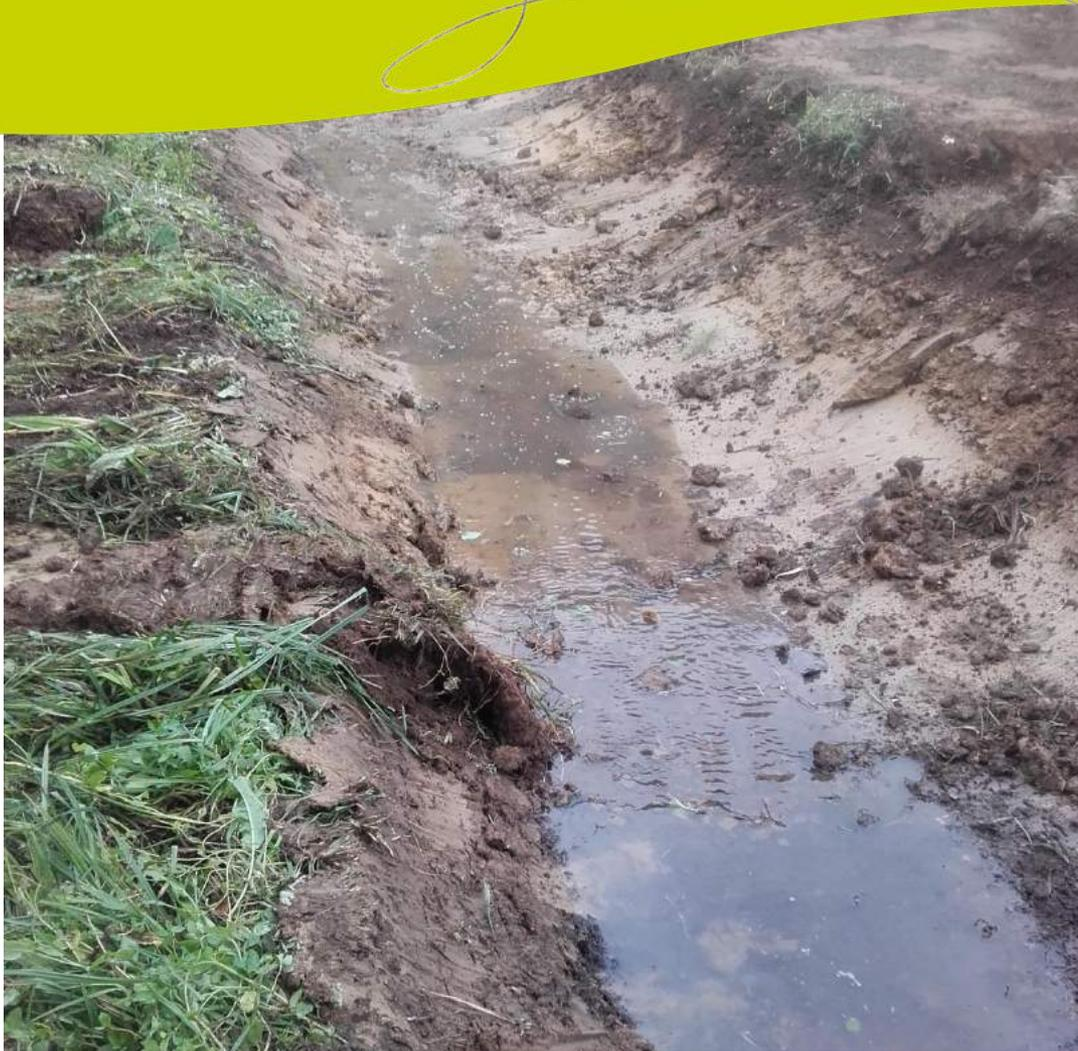
Mise en eau progressivement pour éviter la rupture d'écoulement et le lessivage du sol
