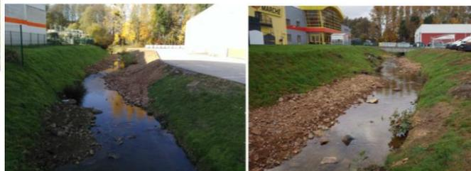
Recharge en granulat sur le Ru de Fimbrune à la Ferté Macé (300 tonnes de granulats)
