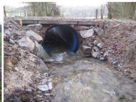
*Mise en place d'un hydrotube (buse PEHD) pour permettre le passage du bétail (localisation inconnue)*
