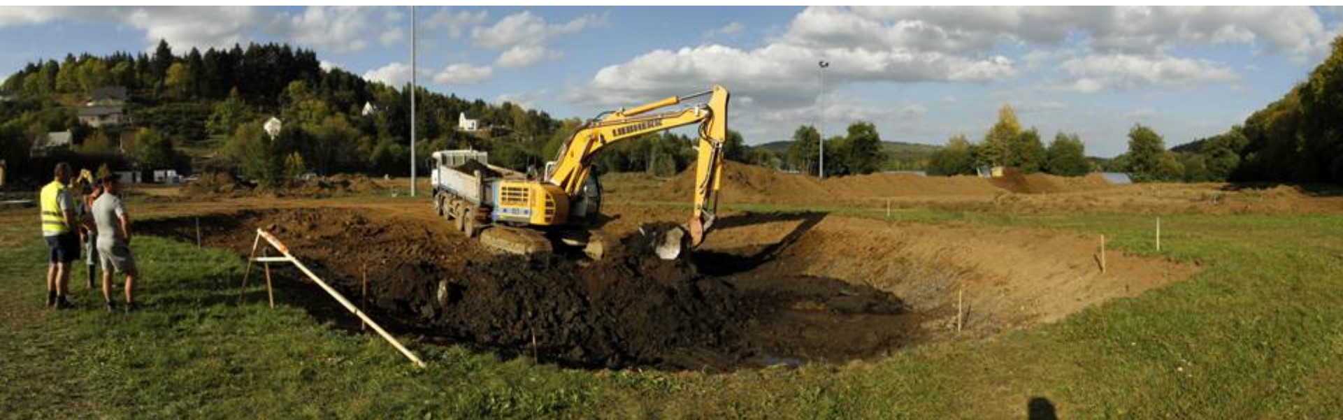
Terrassement de la zone humide
