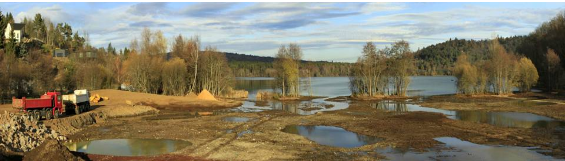
Terrassement de la zone humide
