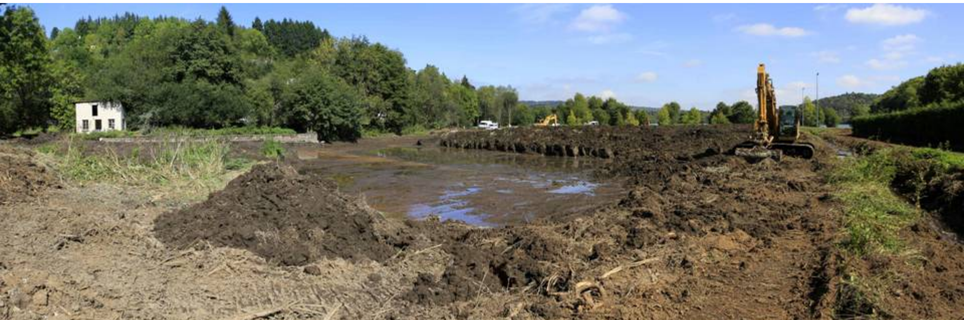
Curage des bassins
