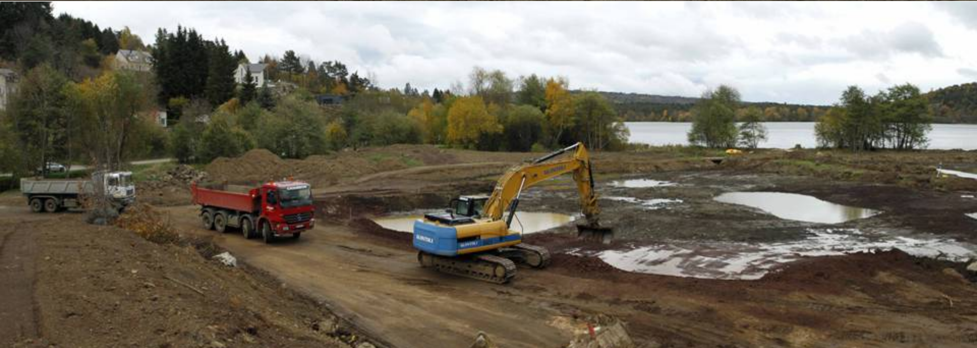
Terrassement de la zone humide
