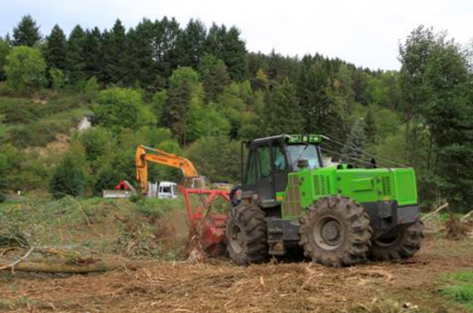
Nettoyage de la végétation
