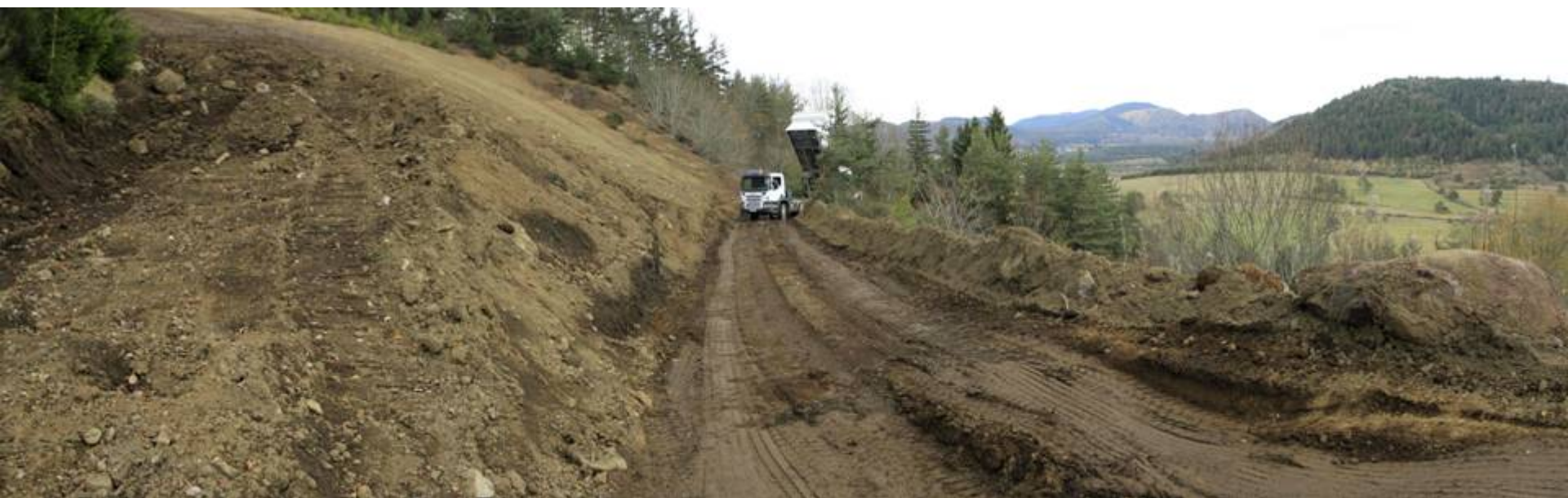
Remblaiement de l'ancienne carrière illégale
