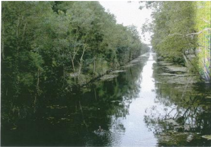
Cette partie d'environ 700m a fait l'objet d'un arrachage, cette prestation a été confiée à l'UNIMA.
