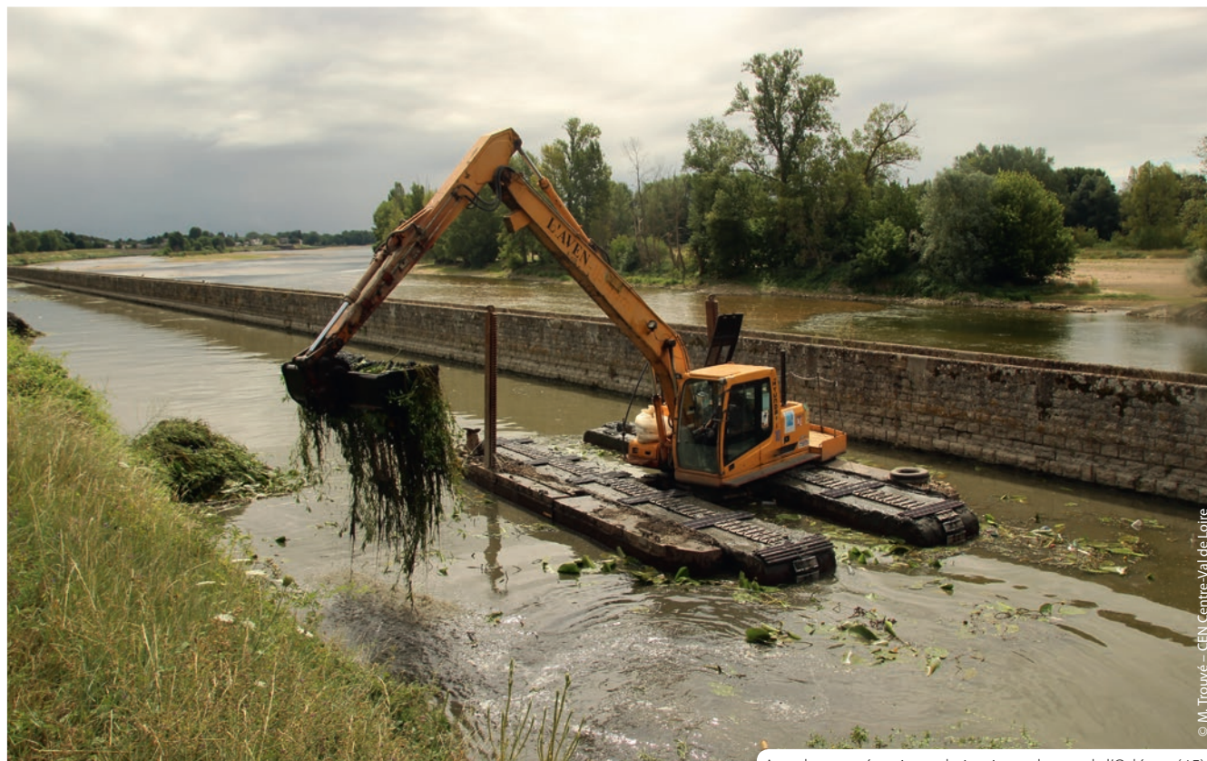
Arrachage mécanique de jussie sur le canal d'Orléans (45).
