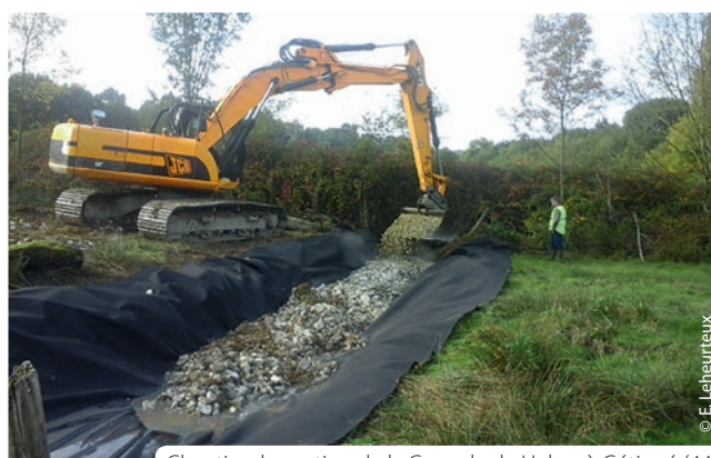
Chantier de gestion de la Crassule de Helms à Gétigné (44).
