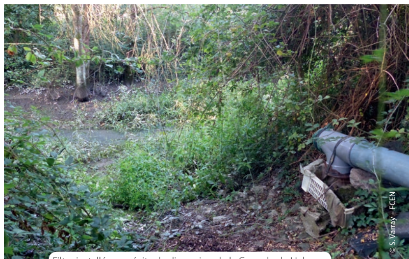
Filtre installé pour éviter la dispersion de la Crassule de Helms sur le site de Tougas (44). © S. Varray – FCEN
