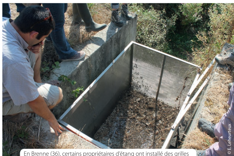
En Brenne (36), certains propriétaires d'étang ont installé des grilles sur les arrivées d'eau afin d'éviter la propagation du Poisson chat dans la chaîne d'étang.
