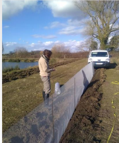
Pose en tension du grillage
