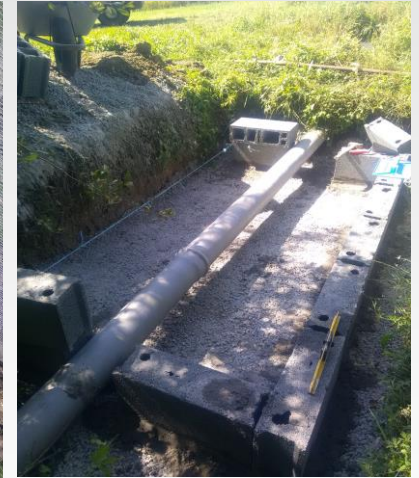
Construction d'un dispositif de filtration
