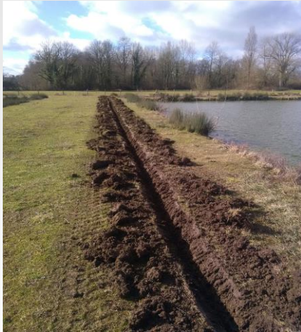
Creusement d'une tranchée
