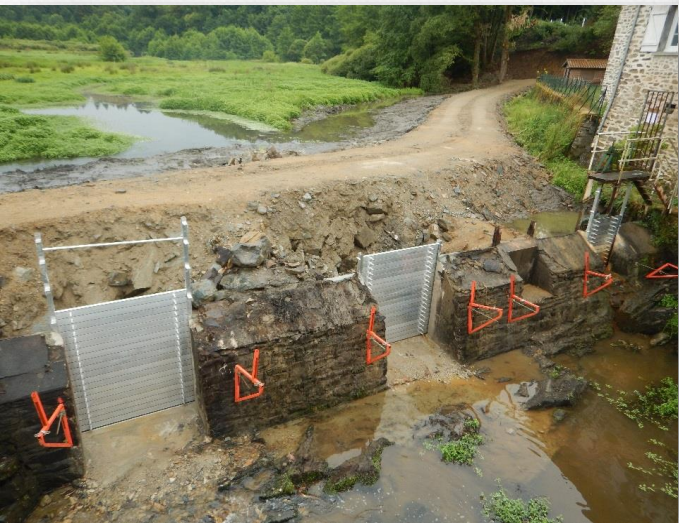
Remplacement des vannes par des planches alu 10 cm
