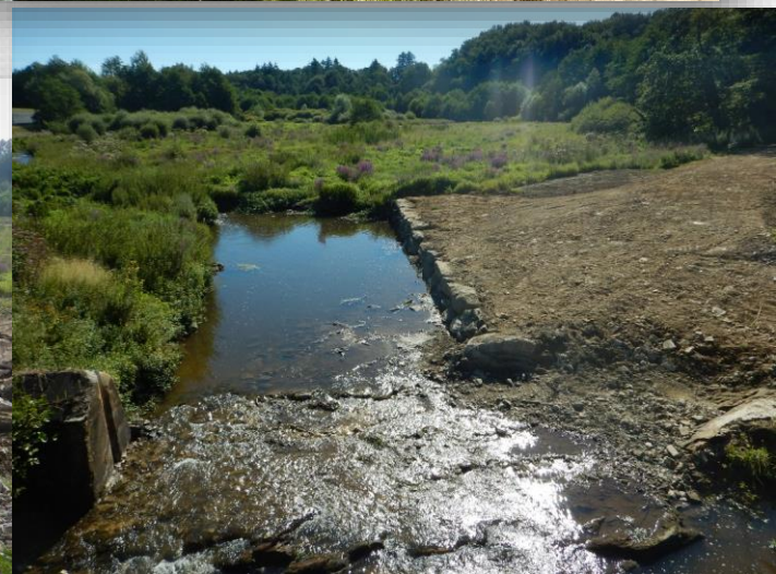
Reprise des berges Remise en état (2020)
