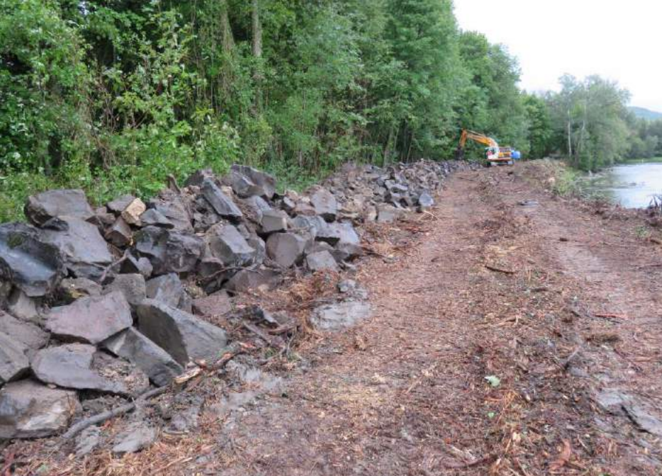
Matériaux entreposés avant reprise et évacuation
