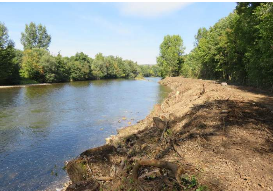
Vue de la berge après travaux en sept. 2017
