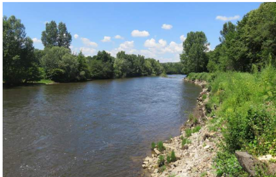
Vue de la berge restaurée en juillet 2018 (après crues de 01/2018 avec 272 m 3 /s, de 05/2018 avec 213 m 3 /s et de 06/2018 avec 205 m 3 /s)
