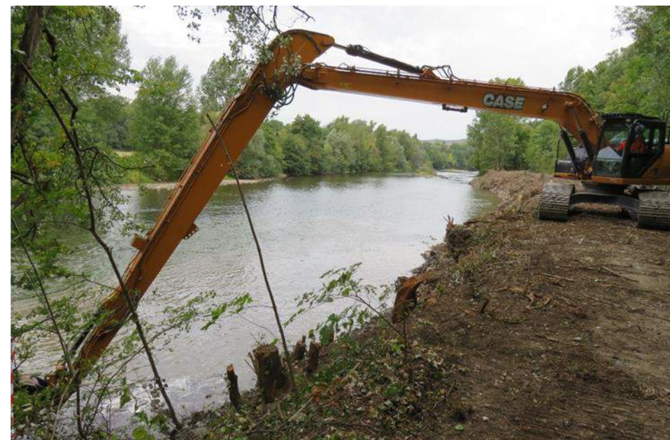
Enlèvement des enrochements les plus éloignés avec la pelle à bras long (capacité 12 m
