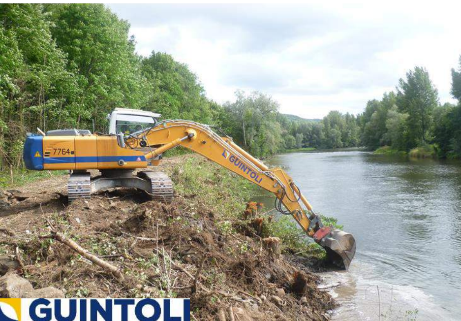
Enlèvement de la protection de berge avec la pelle mécanique
