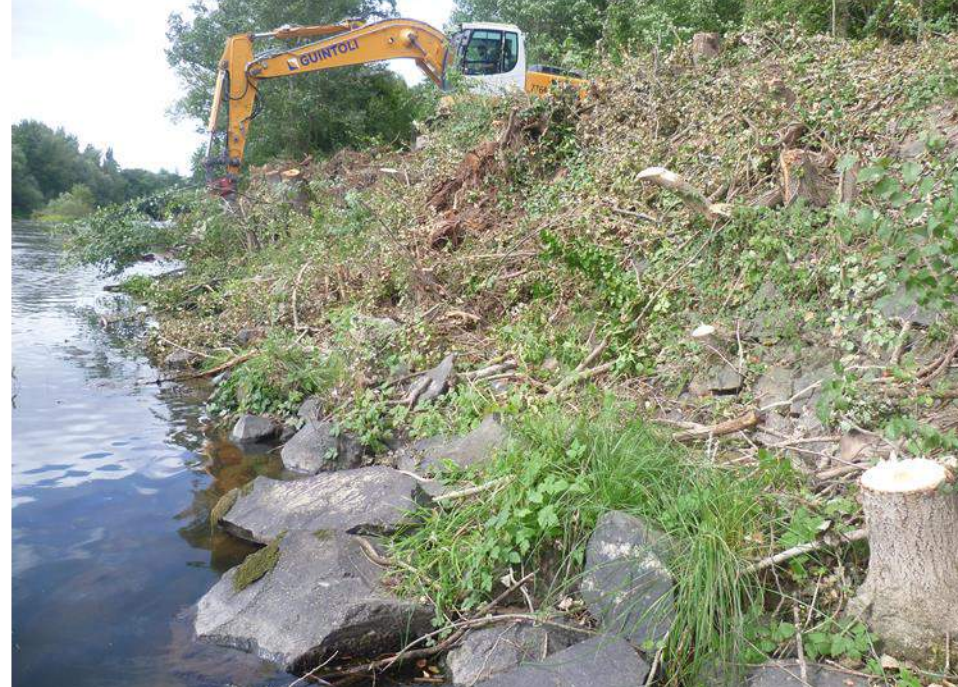
Protection de berge avec le perré, reposant sur la murette en béton non visible, et la risberme en enrochements en pied de berge.
