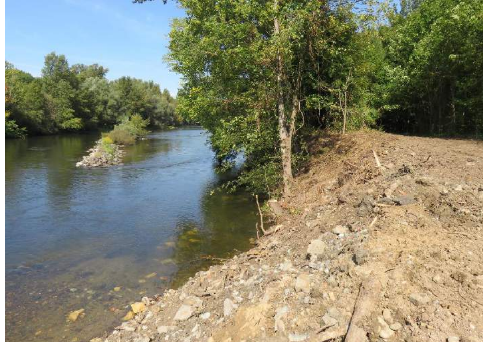
Enrochements retirés dans le lit mineur (sauf îlot au milieu maintenu) (sept. 2017)
