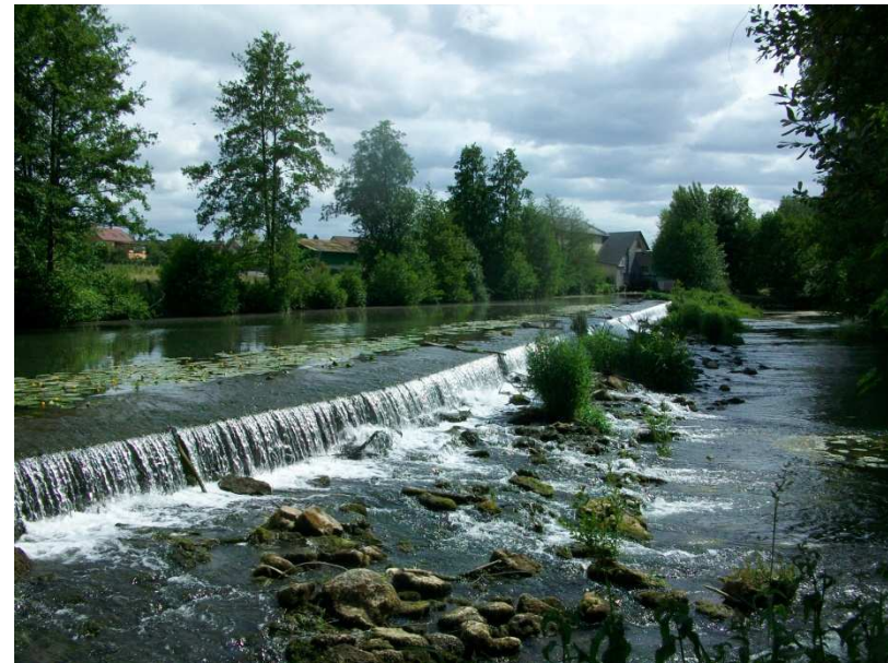
Photo 32 : Barrage de Villaines la Gonais.
