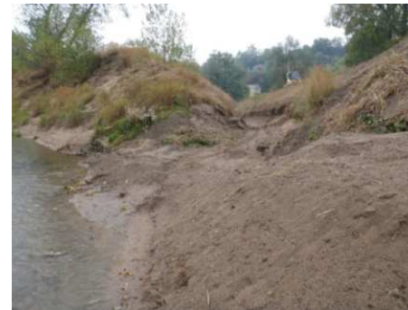
phase travaux été 2009
