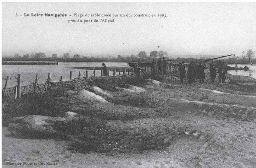
Figure 2 : Le chantier d'installation des épis (phase 1, cf. figure 1)
