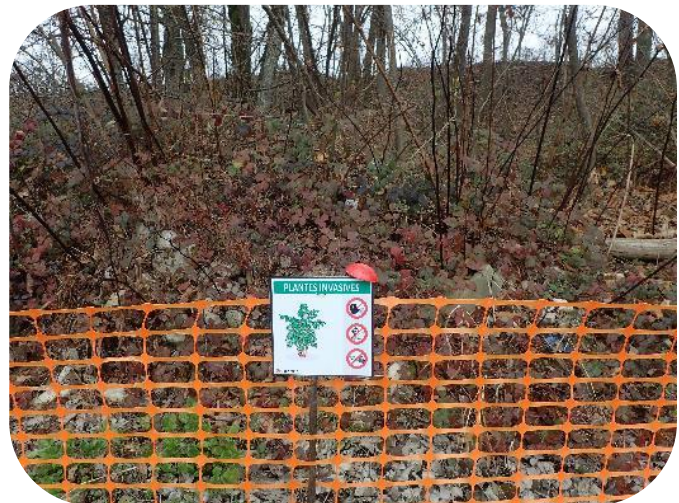
Le balisage et le panneau indiquent que la zone située derrière ne doit pas être traversée par des engins (photo ©Equo Vivo).
