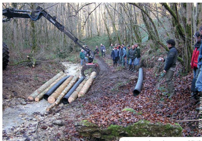
Mise en place de tuyaux PEHD
