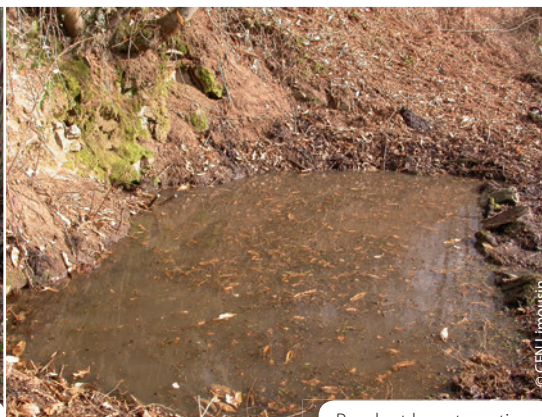
Pendant la restauration
