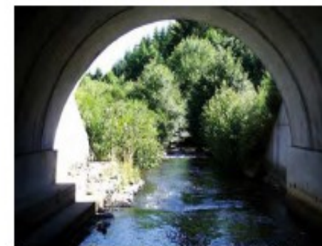
Passage à loutre sur la Cildane (commune de Saint-Julien-Puy-Lavèze) (RN 89). Aménagement efficace de banquettes latérales à l'intérieur de l'ouvrage le long de la paroi.
