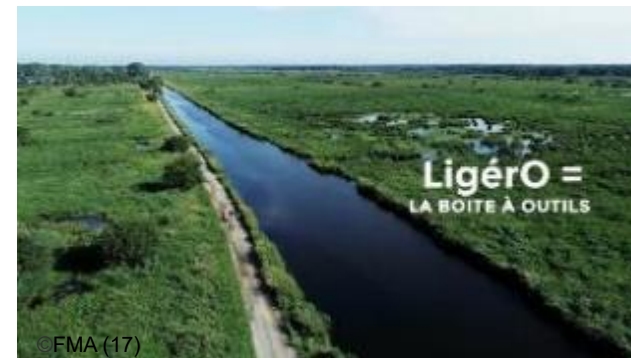
Travaux de curage et suivi évaluation des travaux
