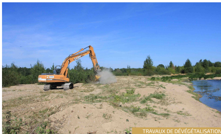
TRAVAUX DE DÉVÉGÉTALISATION
