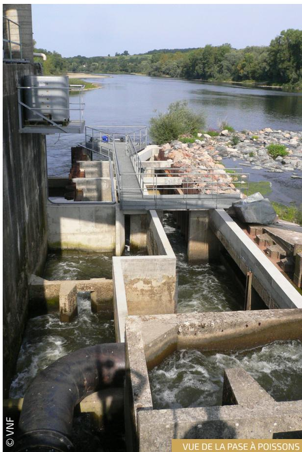
Début 2009, trois bassins ont été ajoutés à l'aval de ceux existants, permettant d'injecter un débit complémentaire d'attrait à l'aval du dispositif, après passage dans deux bassins de dissipation d'énergie. Une vanne mobile a également été installée afin de pouvoir régler la dernière chute aval de la passe.
